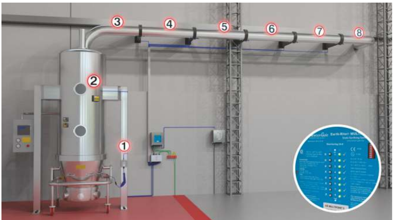
Hier ist beispielhaft ein Earth-Rite MULTIPOINT II-System für die Erdung und Überwachung eines Fördersystems dargestellt, bei dem die Gefahr einer elektrischen Isolierung besteht
